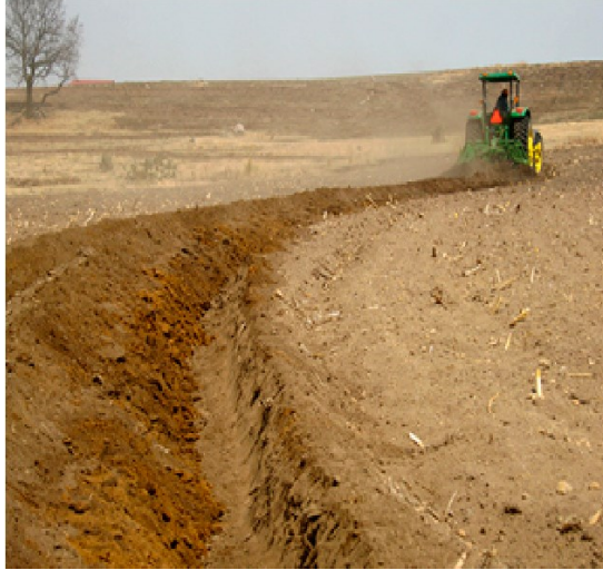
Figura VII- 9. Construcción de una terraza con base en la línea guía trazada. (Fuente: Propia)
