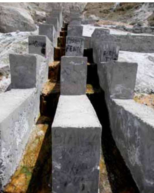
62. Canalización del manantial de agua caliente para bañarse y lavar la ropa, Panamik, Karakorum, India © UNESCO / Olivier Brestin
