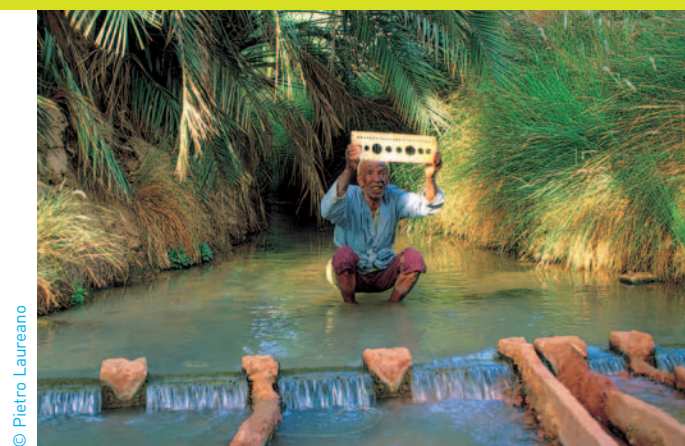
Foto 1: Mit Hilfe des Foggaras-Systems wird Wasser innerhalb der Oase verteilt.
