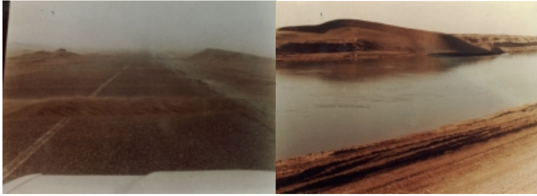
图 4 流沙填埋排灌渠道和威胁其他重要基础设施
