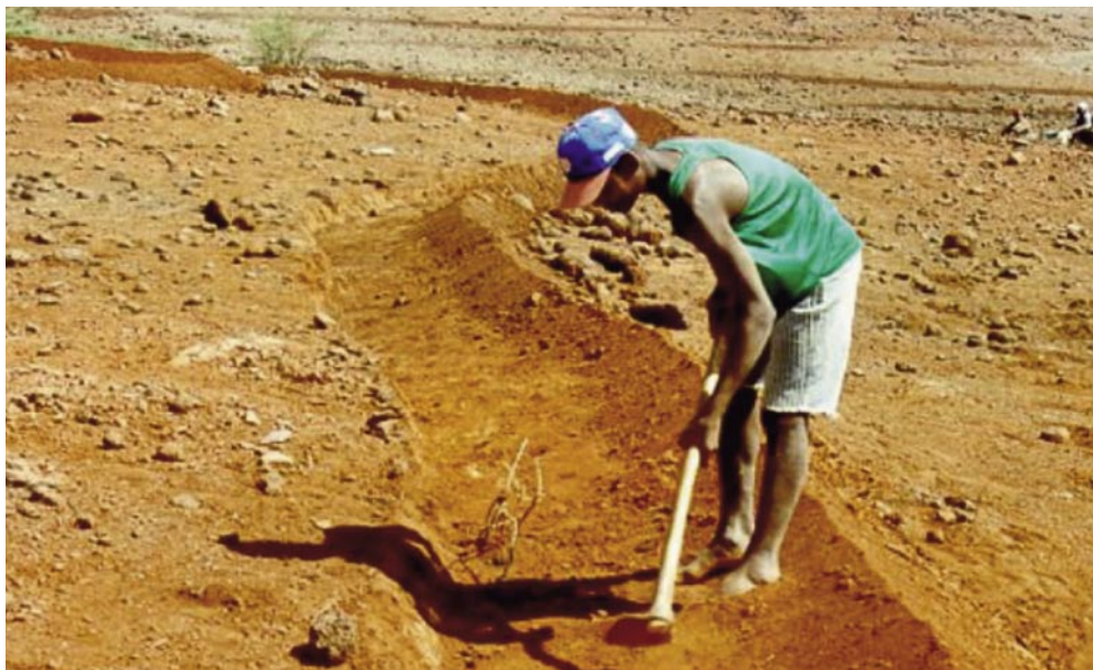
Construction de diguettes en terre
