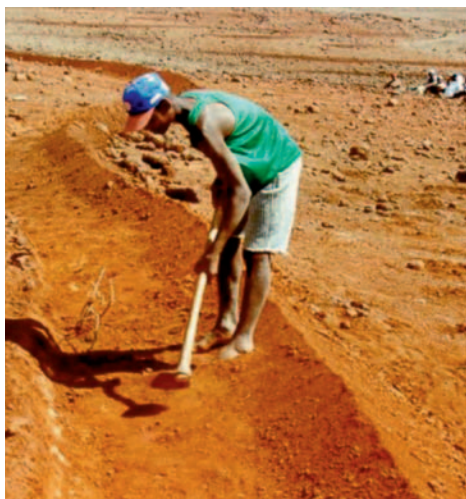
Construcción de un reborde
