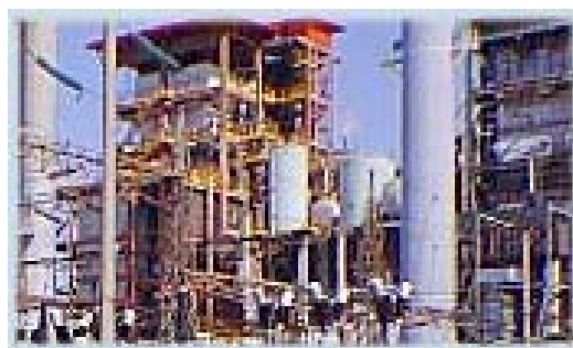
Central Batlle de Generación Térmica
